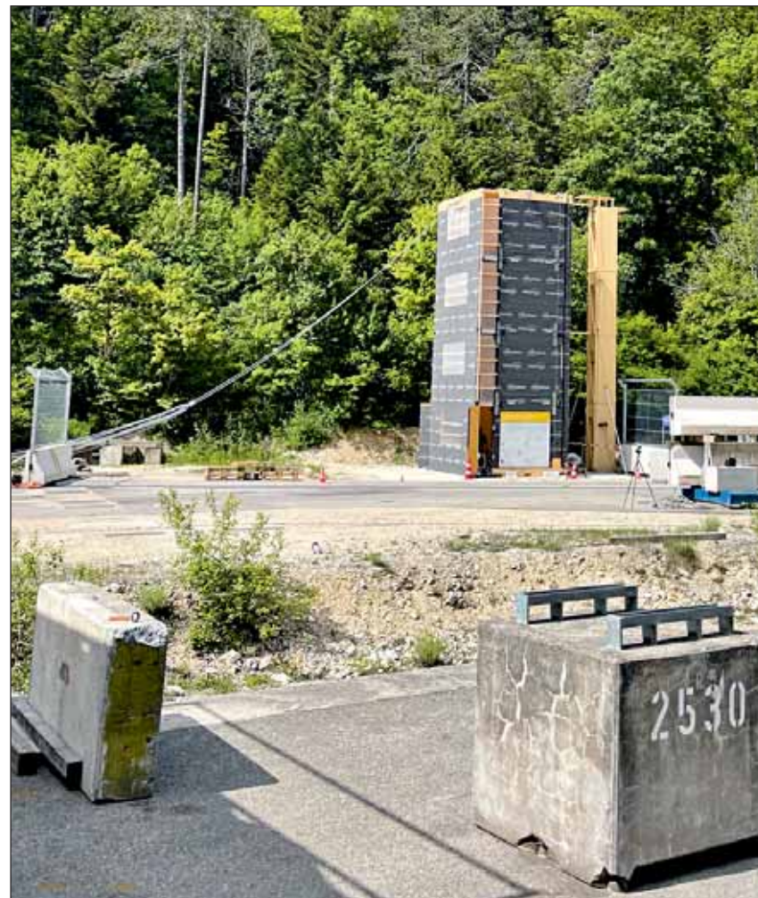
Um Aussagen zur Grundschwingzeit von Brettsperrholzbauten machen zu können, haben Forscher des IHTA eine Reihe von Tests an einem vierstöckigen Gebäude durchgeführt, das eigens zu diesem Zweck gebaut wurde. Foto: BFH
