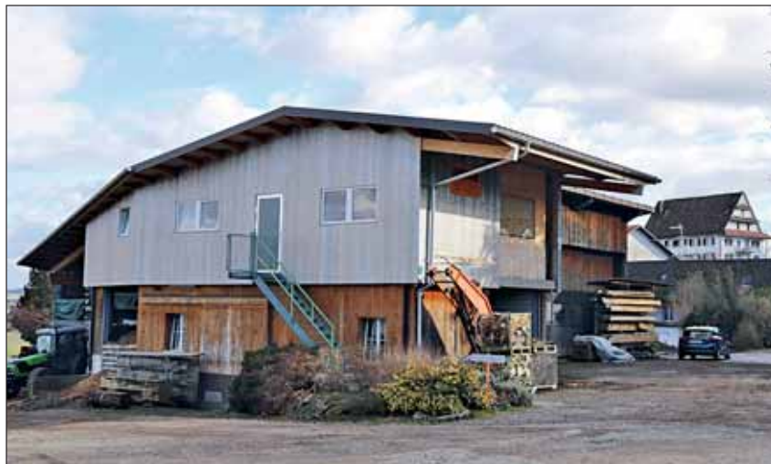
Wittenwil: Die Heizzentrale und das Schloss
