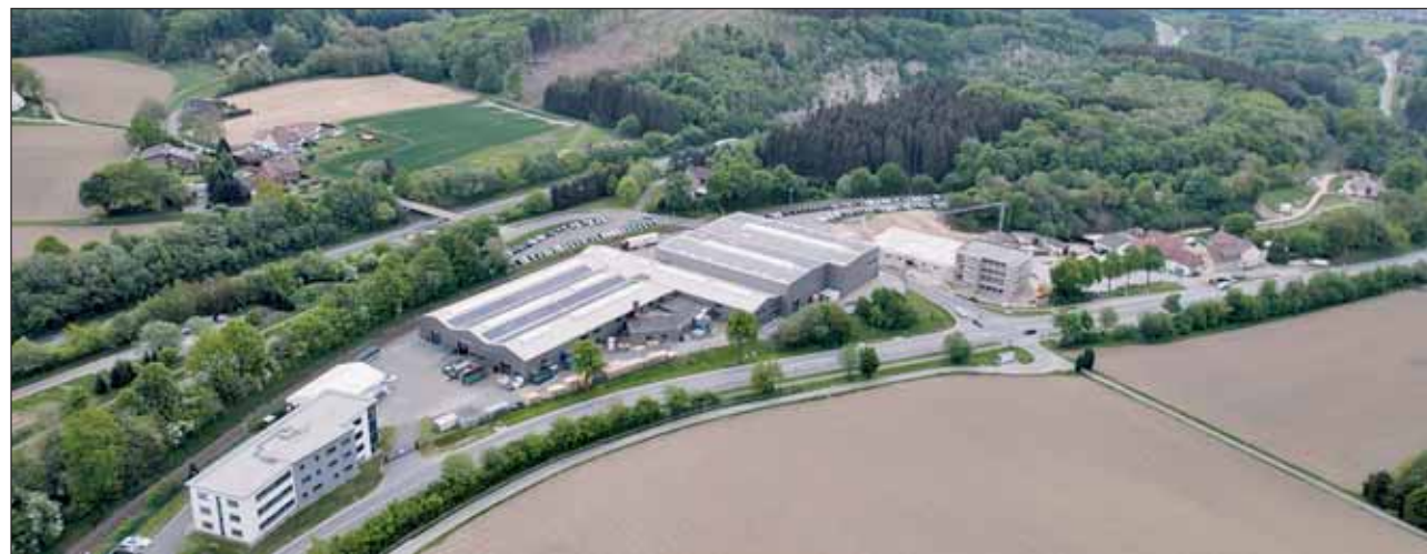
Höcker Polytechnik wächst am Standort Hilter kontinuierlich: Firmengelände im September 2022 – Büro-, Produktions- und Logistikgebäude mit Neubau an der Borgloher Straße Fotos: Höcker Polytechnik
