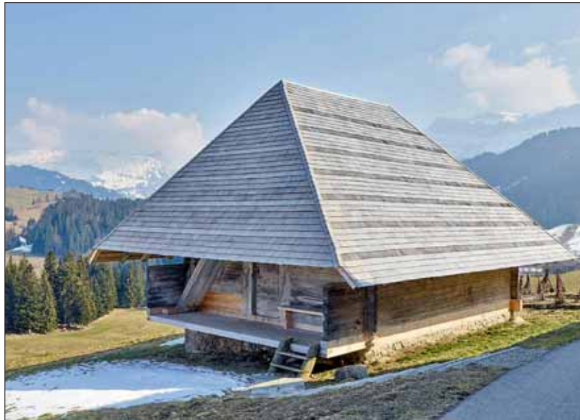
Der renovierte Käsespeicher bei der „Oberen Knubelhütte“ in Eggwil fällt nicht zuletzt durch das sorgfältig ausgeführte Schindeldach auf. Fotos: Dominique Plüss
