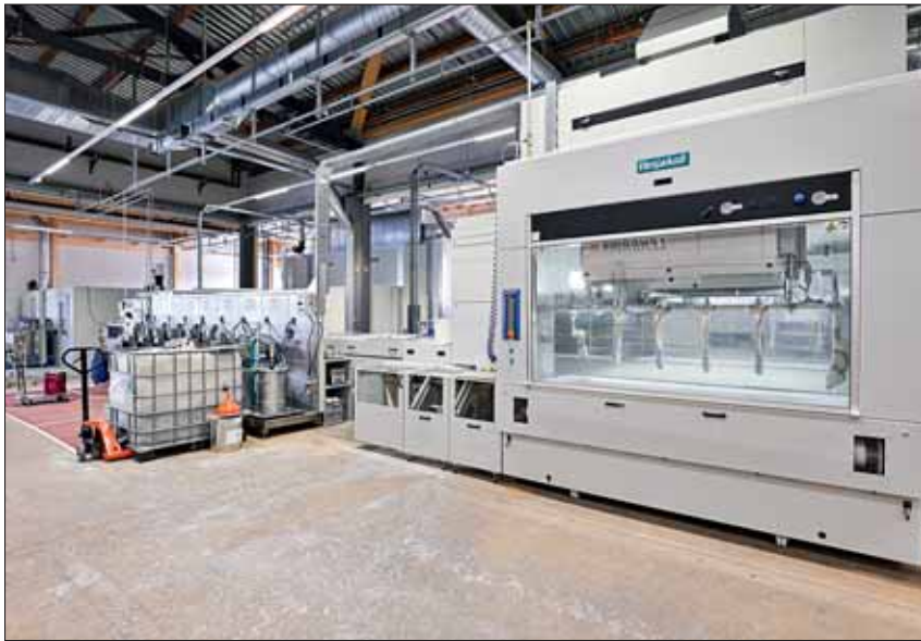
Seitliche Gesamtansicht des Kernstücks der automatischen Spritzlackieranlage von Venjakob bei RWD Schlatter. Links zu sehen ist das umfangreiche automatische Lack- und Farben-Management.
